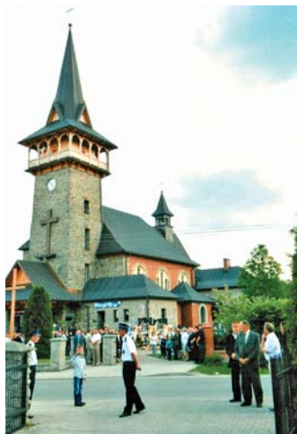
W 2007 r. wymienione zostało pokrycie dachu, a baniasty hełm na wieży zamieniony został na strzelisty ostrostup
