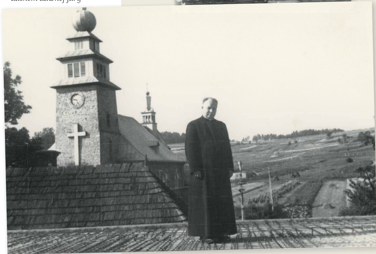
Ksiądz Franciszek Dużyk na stropie powstającej plebanii z widocznym nieopodal dachem dawnej fary
