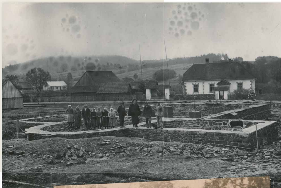
Na fundamentach powstającego kościoła
