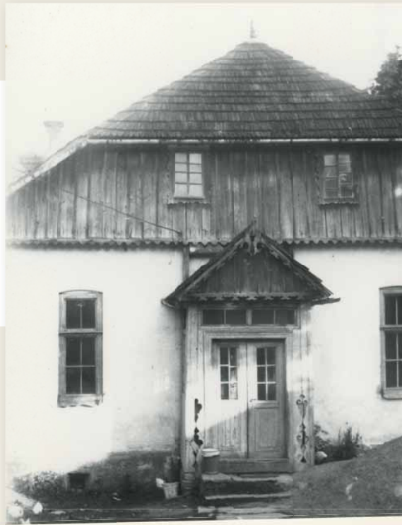
Stara plebania przed rozbiórką
