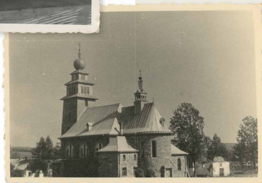
Rozbiórka starego kościoła
