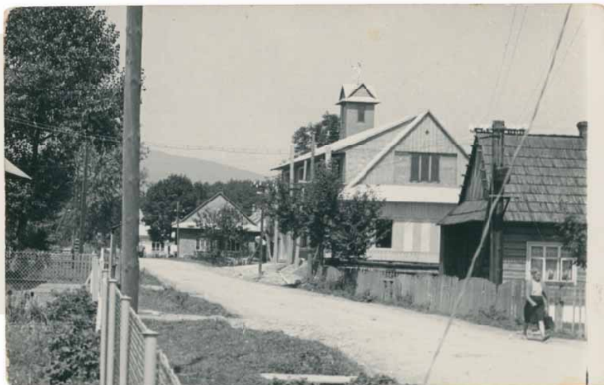
Widok na remizę OSP w Lipnicy Małej podczas budowy, lata 70-te
