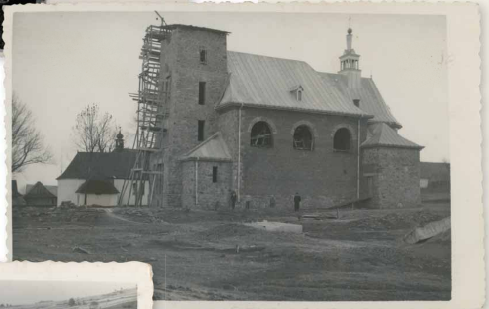
Wznoszenie wieży kościoła
