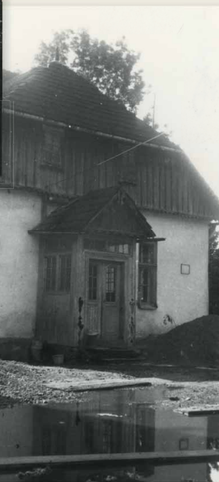
Stara plebania przed rozbiórką
