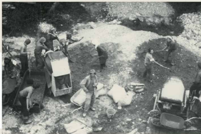
Parafianie pracujący przy wznoszeniu nowej plebanii
