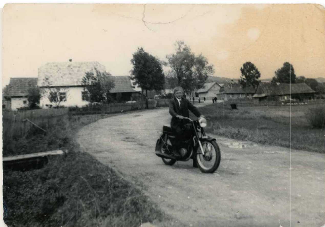
Droga główna przed skrzyżowaniem na Ślamczykówkę
